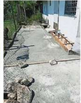
工程組人員除了填平大洞，還為屋主重建了排水溝。
