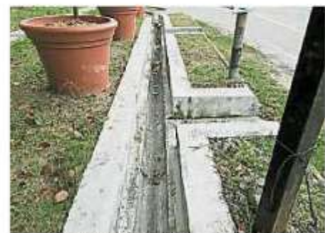
道路旁已增设排水系统, 让路面积水顺利出去。
